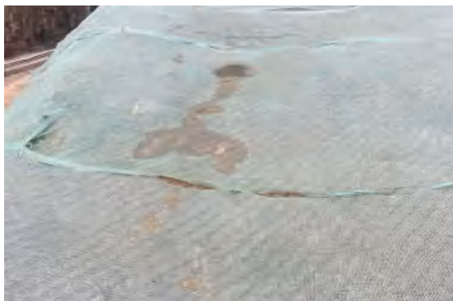
图 17 施工期堆场遮挡覆盖
