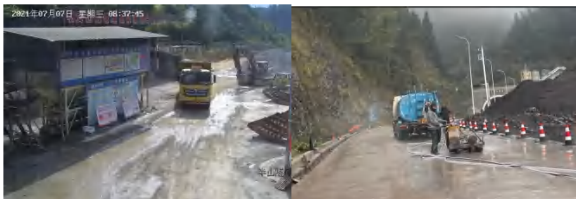
图 18 施工期洒水抑尘
