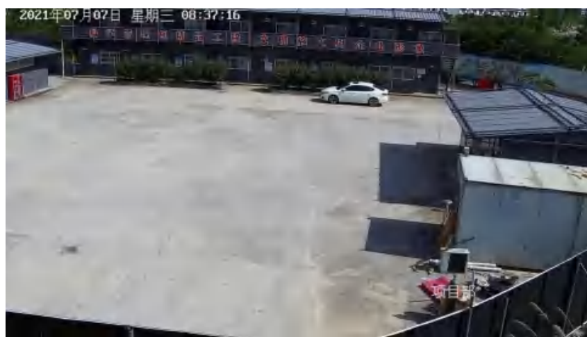
图 19 施工期施工场地硬化
