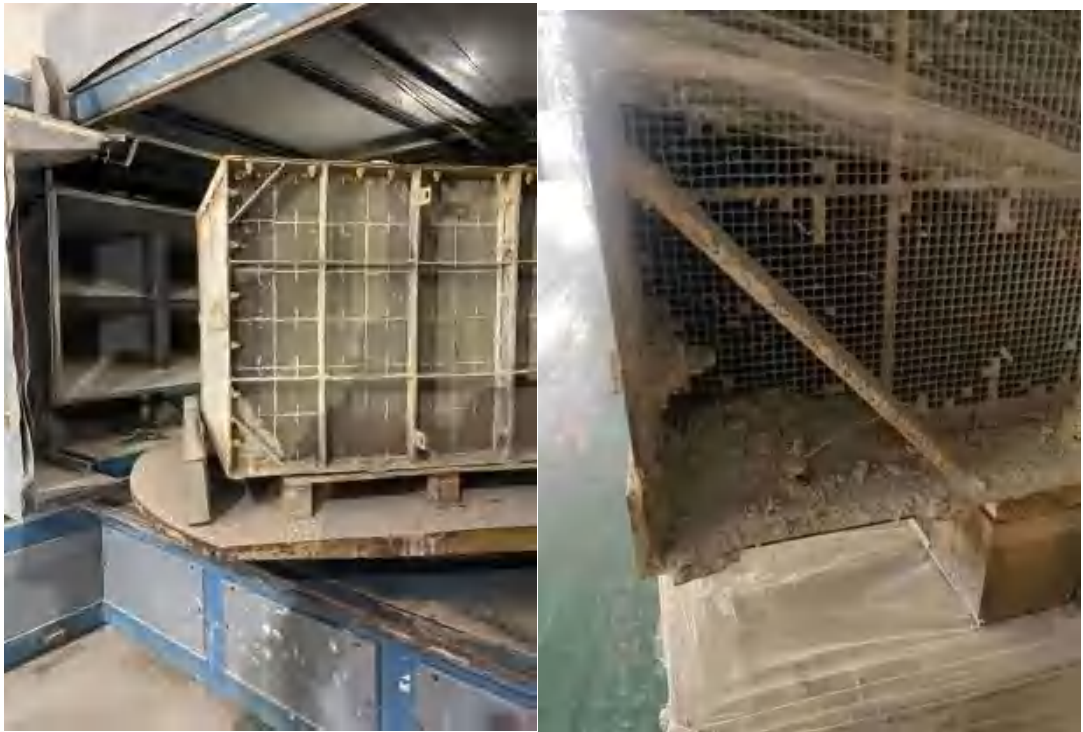
图 3.1-1 入场催化剂清灰前堵塞示意图
