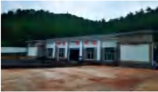
主厂房改造后
