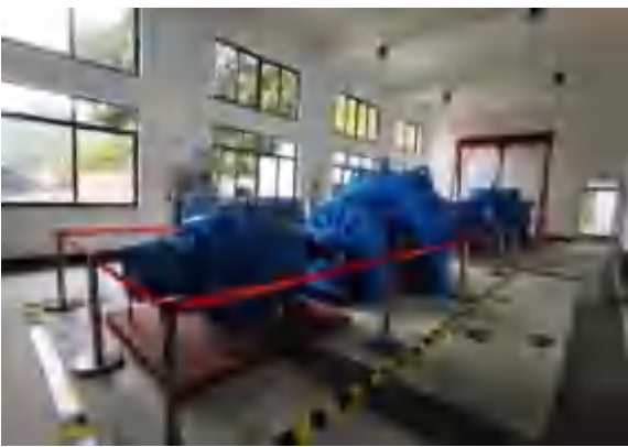
水轮机、发电机改造后
