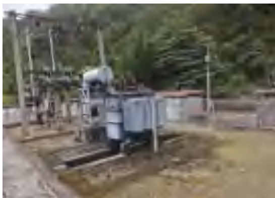
升压站改造前
