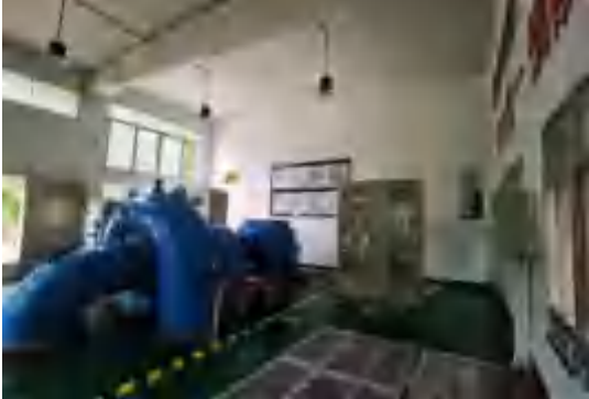
主厂房改造后
