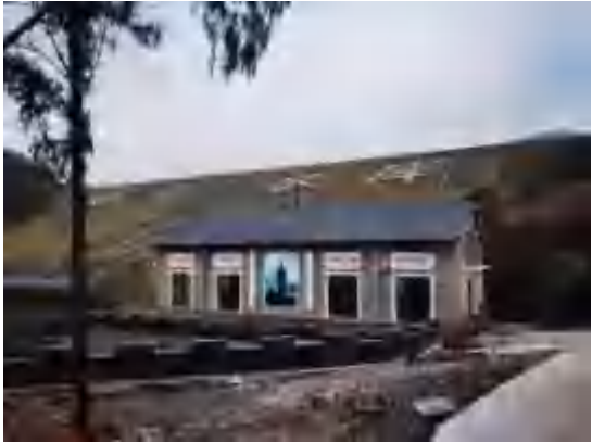
主厂房改造后
