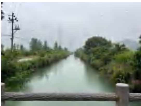
渠道挡墙改造前
