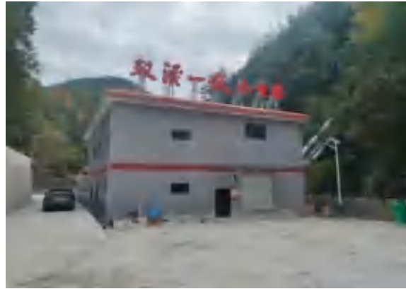
双溪一级水电站
