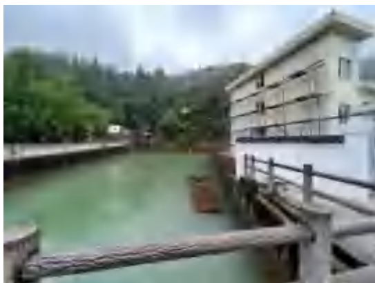
南洞口闸门及周边挡墙改造前
