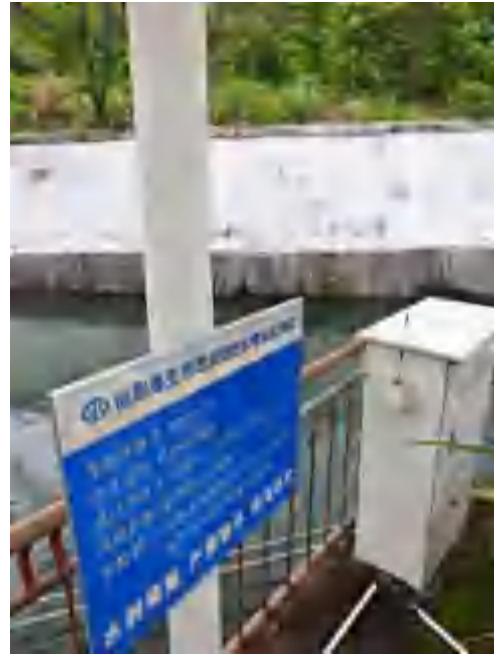
西岙水电站生态流量监测
