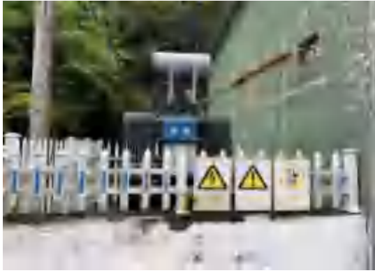
升压站改造前
