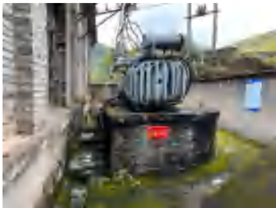
升压站改造前
