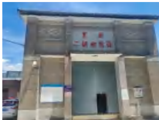
里林二级水电站
