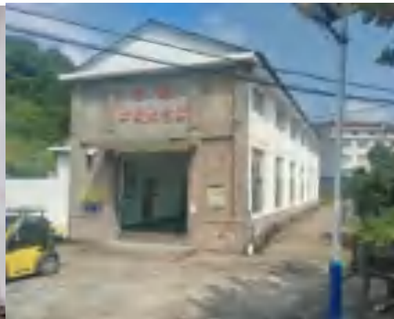
里林四级水电站
