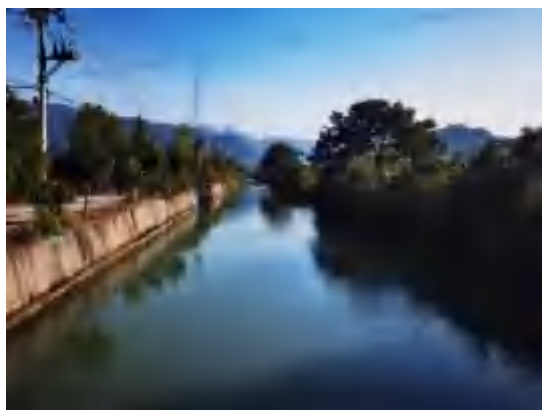
渠道挡墙改造后
