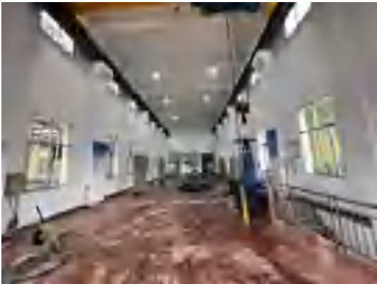
主厂房改造前
