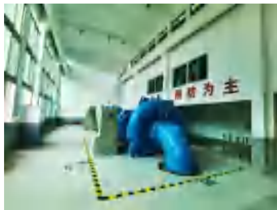
发电机组设备改造后
