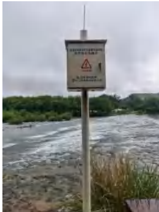
永安水电站生态流量监测
