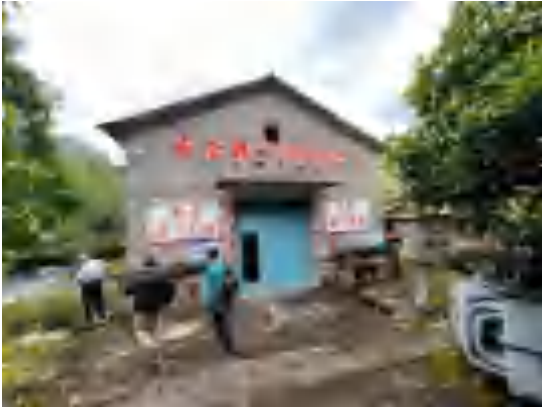
主厂房改造前
