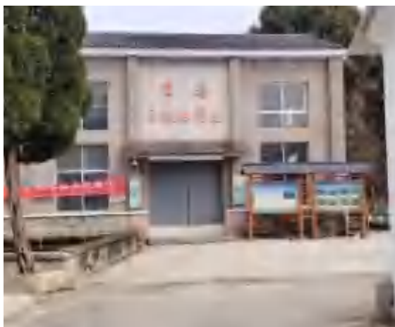
里林三级水电站
